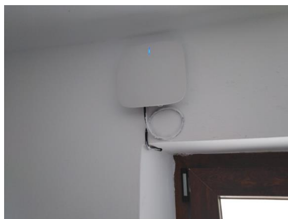
Ilustración 4.- Instalación de AP Interior
